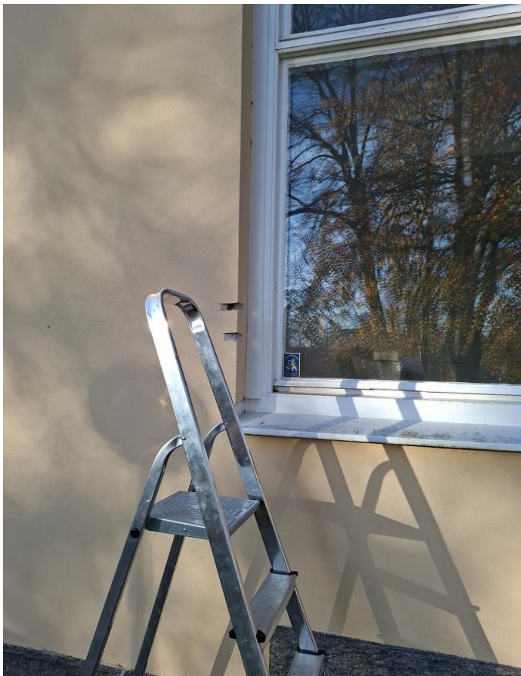
Figur 7 Fasadprov av betong. Materialet skars med vinkelslip och samlades i en plastspann som skurits till för uppsamling.
