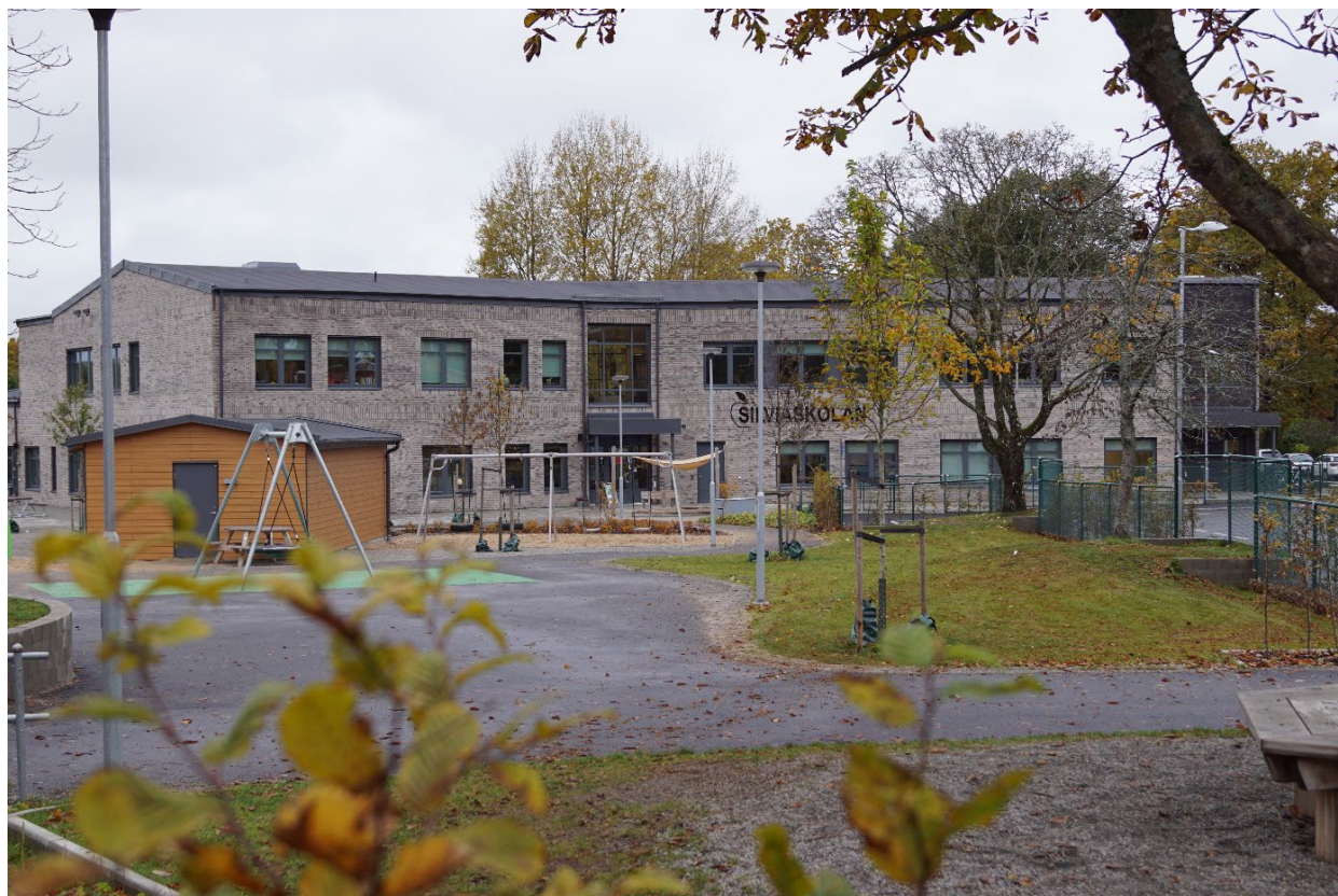
Nybyggnad av Silviaskolan var ett av kommunens större investeringsprojekt som färdigställdes under 2023. Foto: Jonny Persson.
