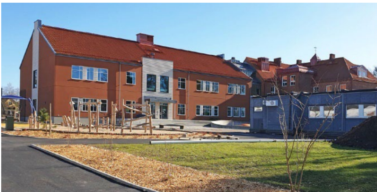
Om- och tillbyggnad av Bjärnums skola är ett av kommunens större investeringsprojekt och som färdigställs under 2023. Foto: Jonny Persson.
