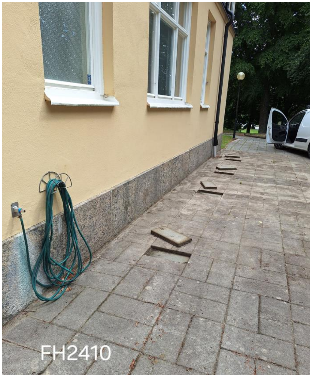
Figur 5 Delprover för FH2410 under betongplattor.
