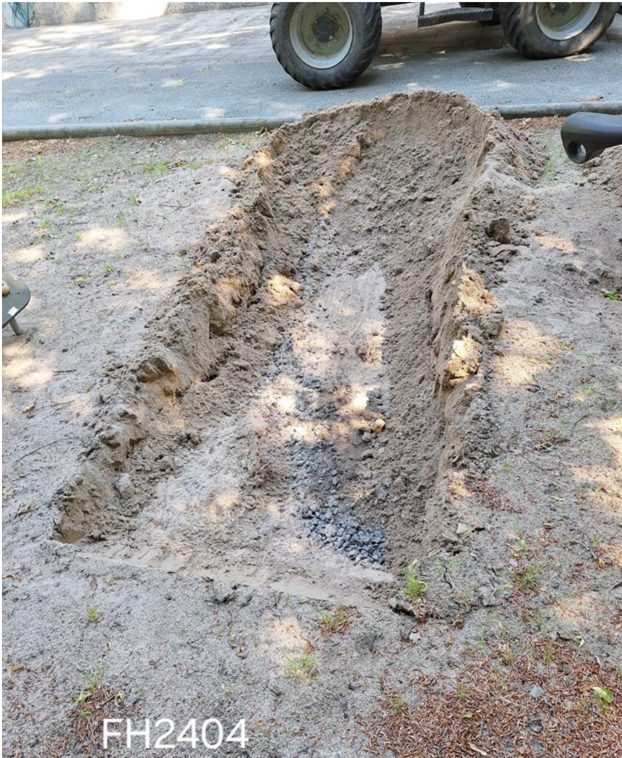
Figur 11 FH2404. Sand i sandlåda med makadamlager och geotextil under.
