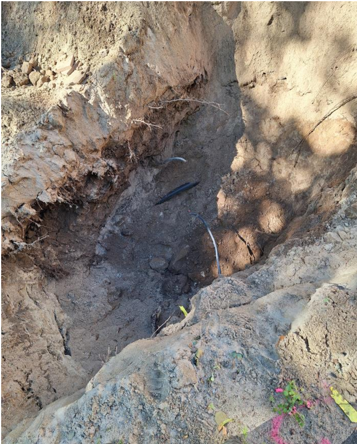
Figur 9 FH2402. Avgrävd elkabel vid 0,8 m djup. PEM-slang vid ca 1 m djup.
