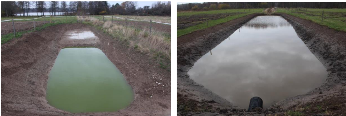
Figur 27. Fosfordammar vid sjön Nimmern 25 oktober 2019, anlagda några veckor innan fotona togs. Dammarna har gjorts i anslutande diken med syfte att bromsa vattenflödet och låta fosfor bunden i partiklar sedimentera. Notera hur det redan syns skillnader i vattenfärg och algtillväxt. Foto: Carl-Johan Månsson
