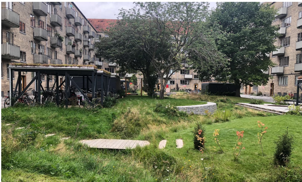
Figur 19. Exempel på en delvis nedsänkt yta för fördröjning av skyfall inom ett bostadsområde. Bild av Tyréns AB.
