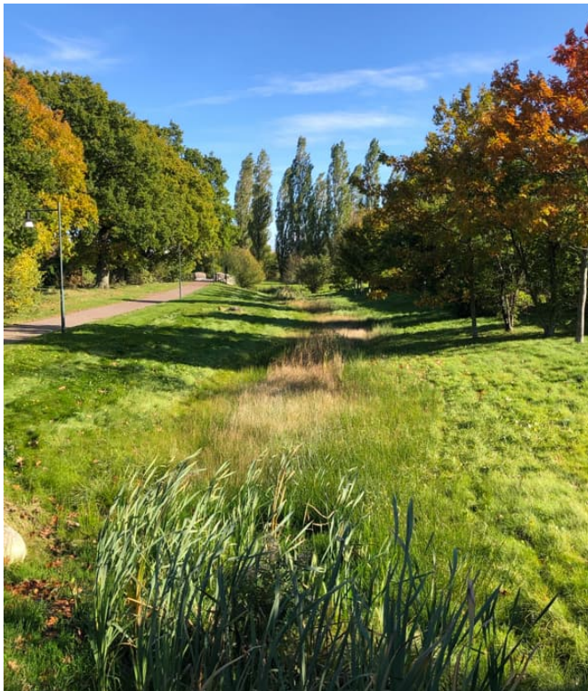
Figur 20. Exempel på svackdike i grönyta. Bild av Tyréns AB
