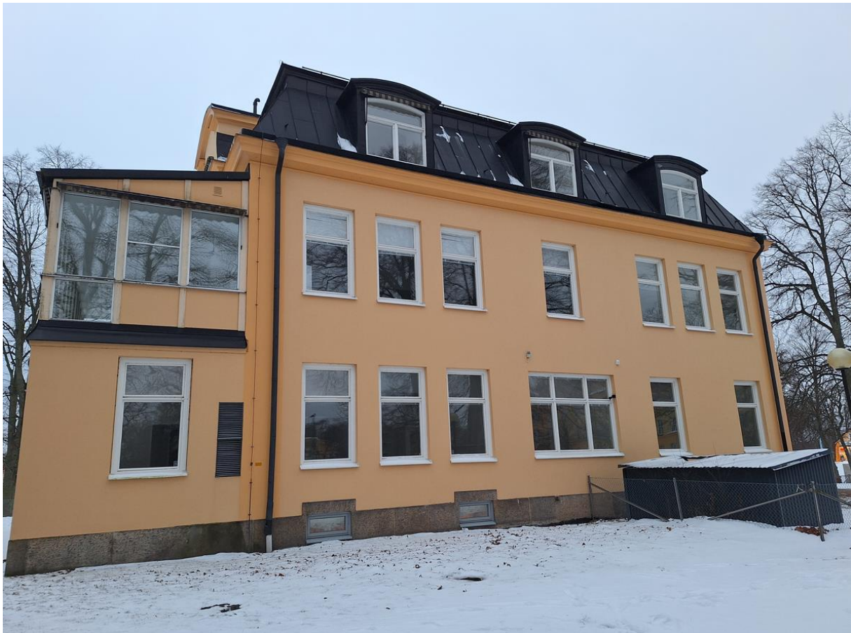
Figur 2 Fasad mot öster 2024. Fönster från tidigt 1990-tal har ersatt de ursprungliga. En veranda-liknande tillbyggnad har gjorts på andra våningen på sydsidan. Huvudingången har flyttats från östra till norra sidan (syns ej i bild).
