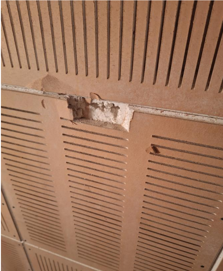
Figur 12 Gipsliknande isoleringsplattor i innertak mellan våning 3 och vinden. Provtagning har gjorts (prov "Isoler") och ingen asbest förekommer i materialet.
