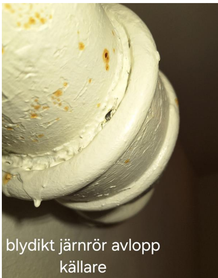
Figur 16 Äldre avloppsledning av gjutjärn med blydiktning i skarven. Metallisk bly kan ses genom att skrapa genom den vita färgen.
